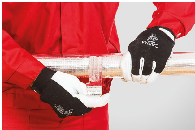
7. Kevalų sandūra užključuojama lipnia aliuminio juosta
