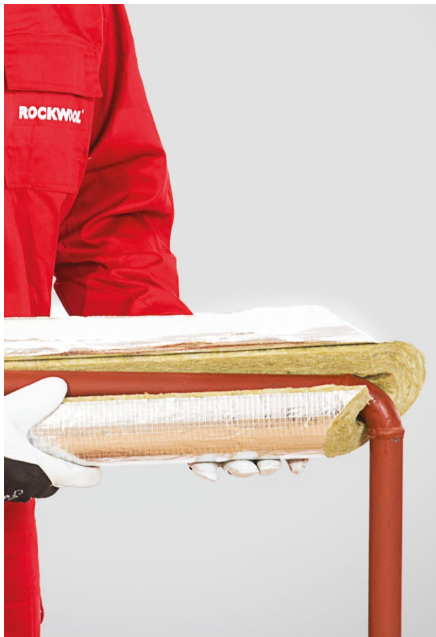
3. Pirmosios izoliacijos dalies uždėjimas ant vamzdžio
