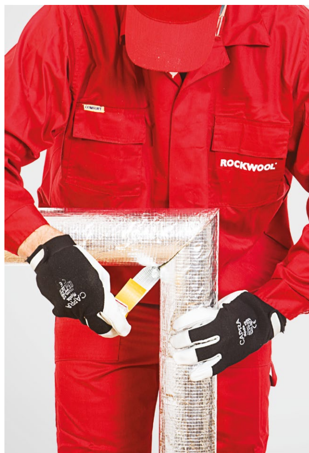
6. Skersinių kevalų sujungimo (sandūros) klėjimas lipnia aliuminio juosta
