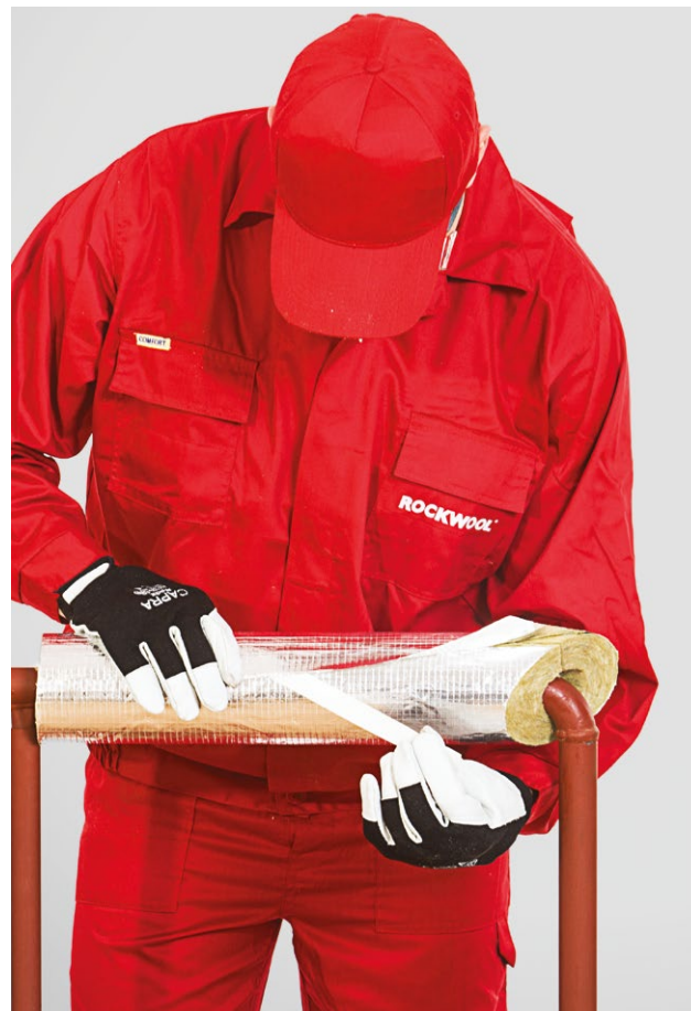
4. Išilginės kevalo įpjovos užklėjimas lipnia užlaida
