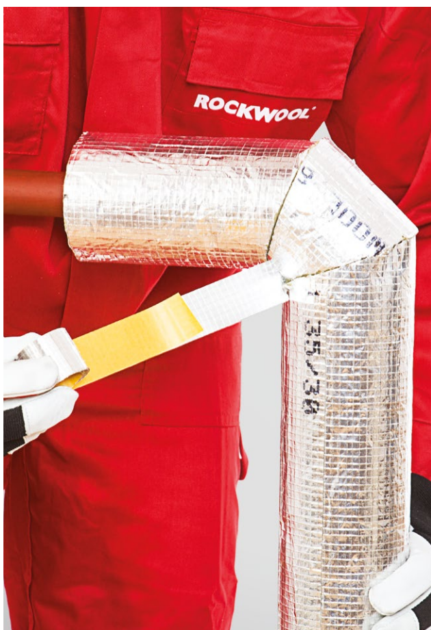
7. Skersinių sujungimų klijavimas lipnia aliuminio juosta
