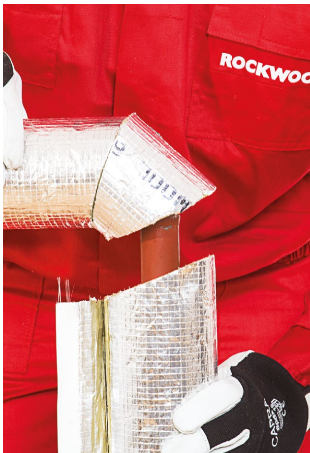
5. Tiesiosios izoliacijos dalies montavimas
