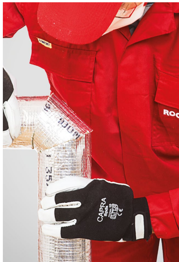
6. Visų dalių tikslus sujungimas
