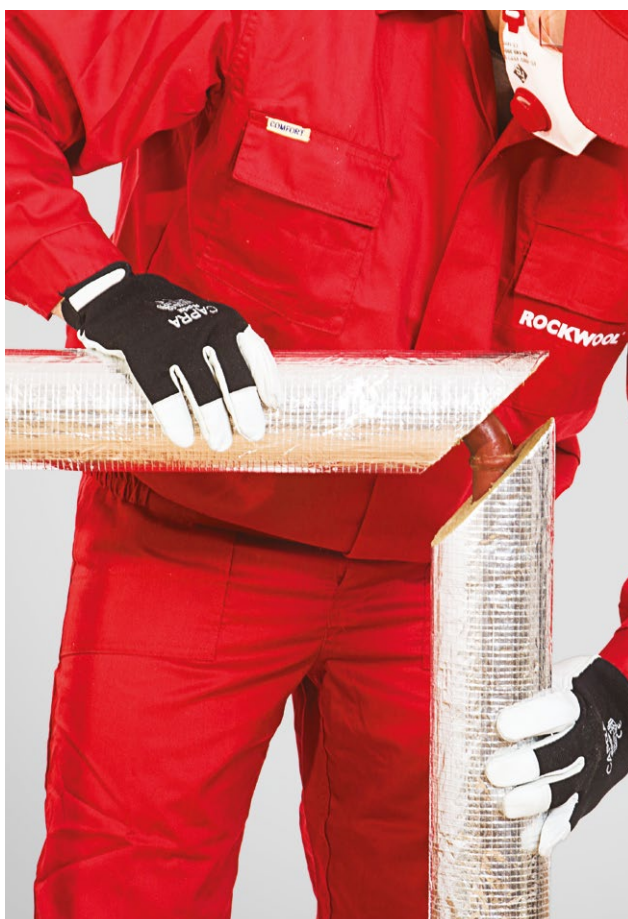
5. Alkūnės izoliacijos abiejų dalių sujungimas
