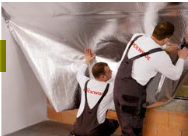
Napnutie parozábrany
