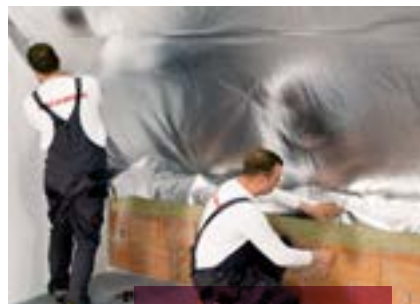
Prilepenie parozábrany k stene
